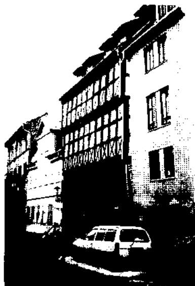
Saniertes Wohnhaus, Erfurt
